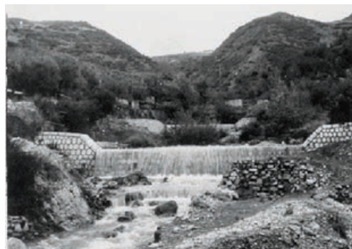
Δείγμα σειράς λιθόκτιστων φραγμάτων από την Δασική Υπηρεσία τη δεκαετία του '50 στο χείμαρρο Γλαύκο Αχαΐας (Αρχειό Δ.Υ.)
